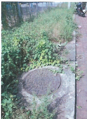
Bể tự hoại 3 ngăn khu vực nhà kiểm soát hải quan
